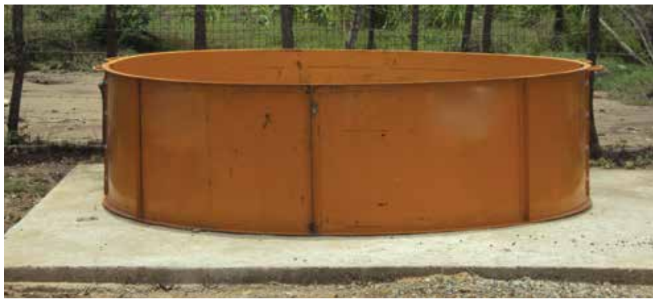
Figura 3. Silo de anillo sobre plataforma de hormigón
